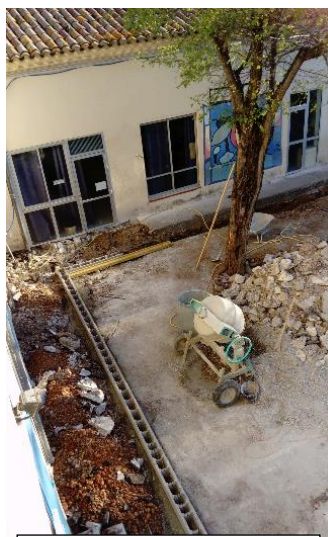
Création de la rampe d'accessibilité dans la cour des maternelles.
