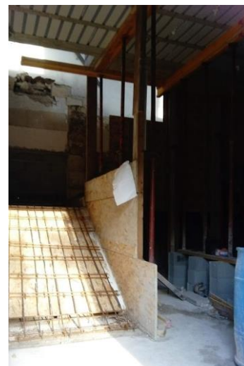
Nouveau plancher et préparation de l'escalier pour deux nouvelles classes : CM et GS
